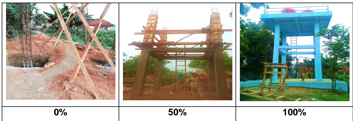
Foto Kegiatan Pembangunan Sumur Bor Kecamatan Semendawai Barat Kabupaten OKUT
