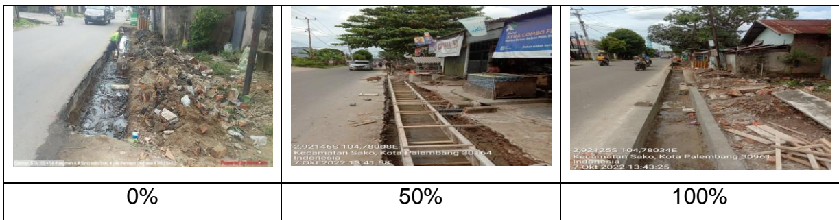
Foto Kegiatan Pembangunan Drainase PSU Sako Palembang
