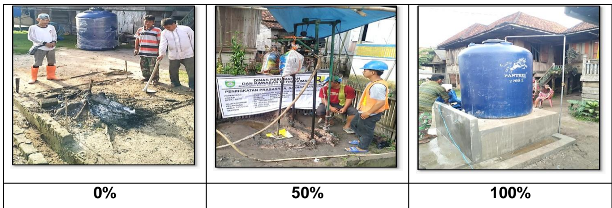
Foto Kegiatan Pembangunan Sumur Bor Kecamatan Tulung Selapan Kabupaten OKI
