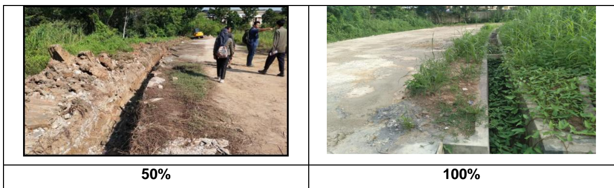
Foto Kegiatan Pembangunan Drainase Pada Kawasan Dekranasda Palembang
