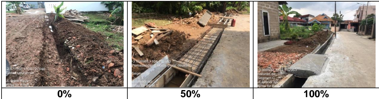
Foto Kegiatan Pembangunan Drainase PSU Ilir Barat I Kota Palembang
